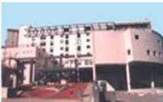
HOSPITAL DO SAMS Rua Cidade de Gabela, 1 - 1849-017 Lisboa
